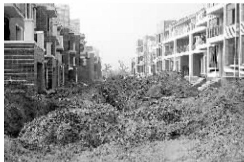
淼岳林庄园低层联排住宅间正在铺设管道
