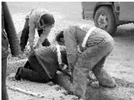
工人正在郭守敬大道上砌路沿石
