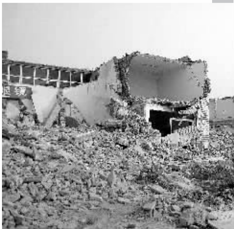
豫西市场片区改造拆迁现场。
