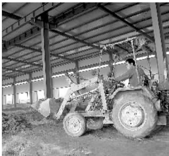
通利公司年产1万吨钢丝制品施工现场。
